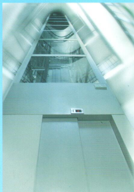
Exemplo de estrutura interna
